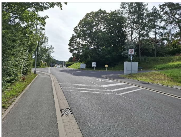
Abbildung 4: Knotenpunkt "Baumhofstraße / Nikolausweg", eigene Aufnahme vom 16.07.2024
