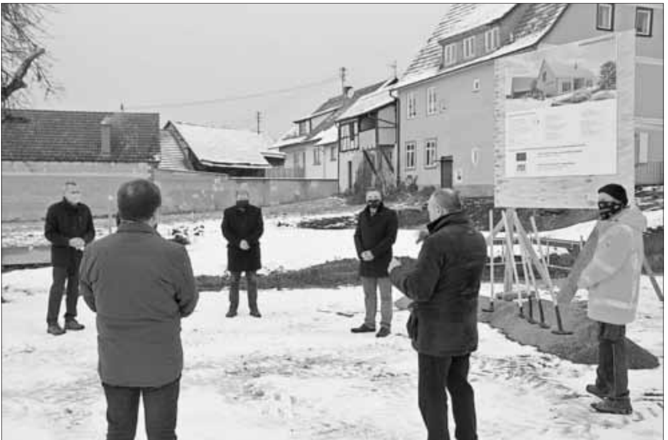
Am 2. Dezember 2020 fand der Spatenstich für das Bürgerhaus Michelrieth statt.
